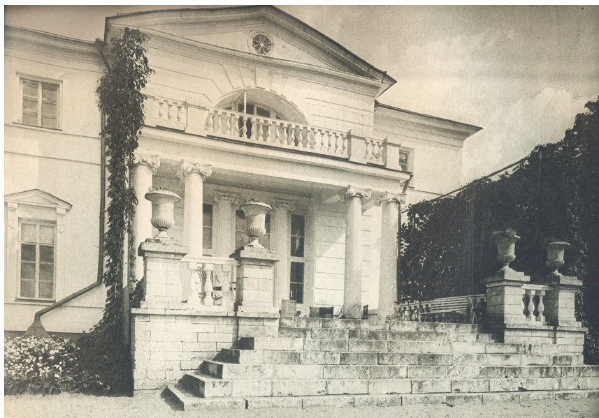
Рис. 1. Главный усадебный дом Щербатовых в Братцево. Фотография. 1910-е гг.
